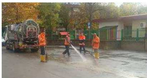
Ripulitura dal fango dopo gli allagamenti di ieri
